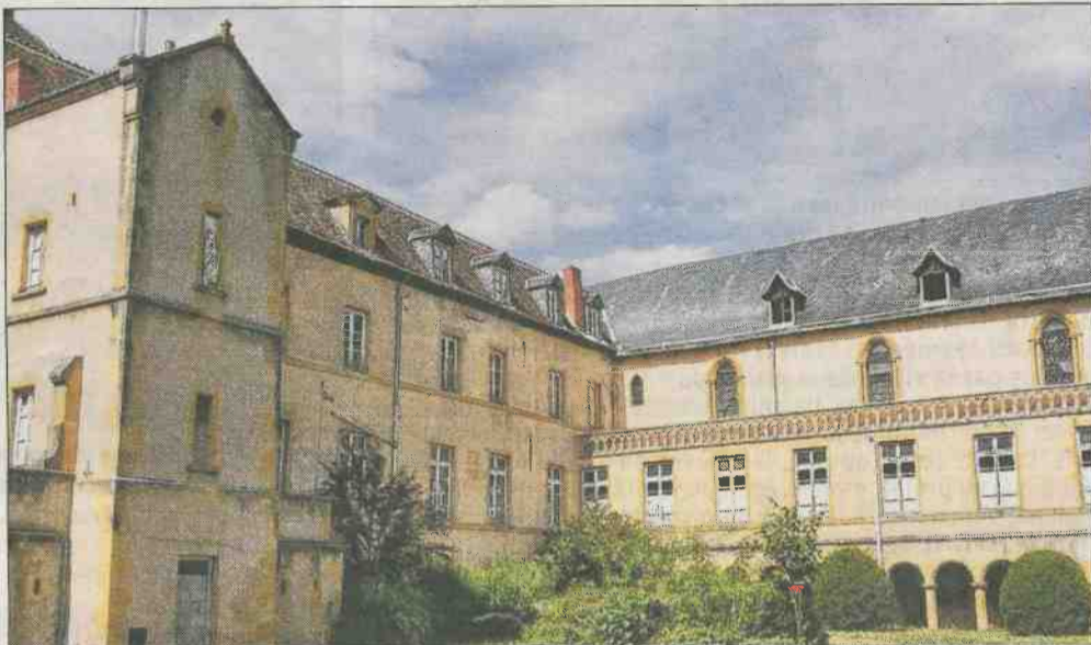
Saint Gildas va être complètement rénovée et devenir une résidence senior d'exception.
